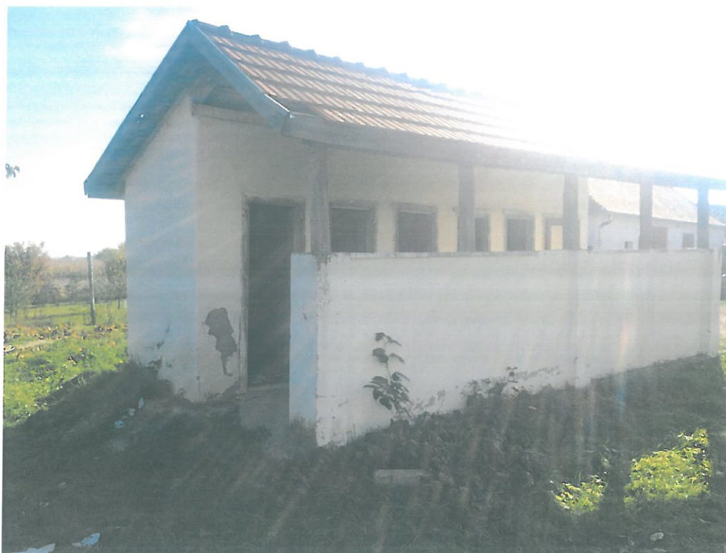
Foto nr. 2 – Imagine din exterior.
