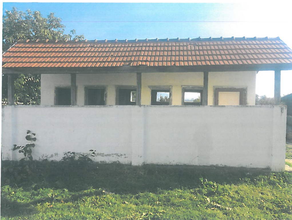
Foto nr. 1 – Imagine din exterior.
