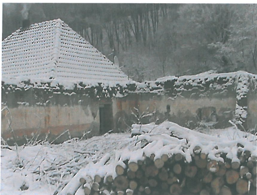
Foto nr. 1 – Imagine de pe amplasament. Se observa ca pe amplasment mai sunt ramasi doar cativa pereti din fosta scoala.
